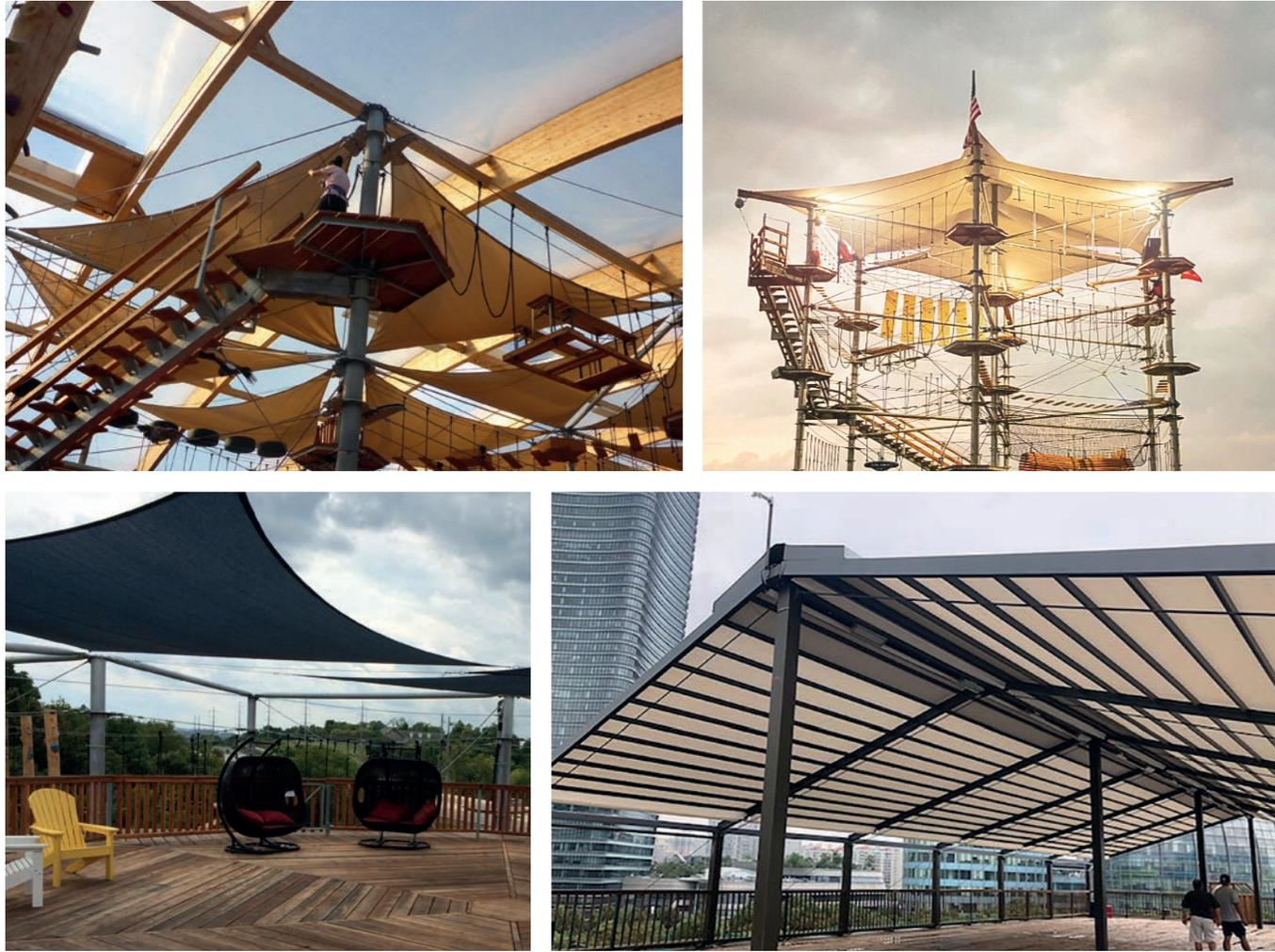
Jeder Kristallturm® Hochseilgarten kann ganz oder teilweise überdacht werden und bietet seinen Gästen, je nach Ausführung, einen Sonnen- und / oder Regenschutz. Die Möglichkeiten der Überdachung reichen von einem einfachen Sonnensegel bis hin zu automatisch aufrollbaren Dachflächen oder einer zirkuszeltähnlichen Haube.
